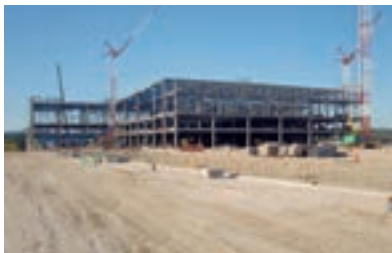
二野工場建設風景（2013年5月）
