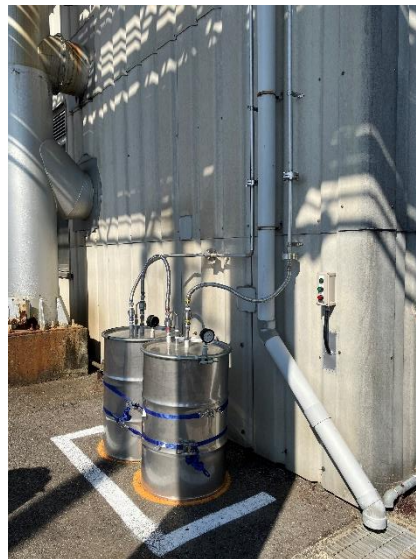
<集積装置で精製された CO 2 を貯蔵するドラム缶>
