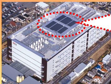
北地区第14工場 上空写真
