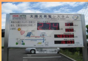
太陽光発電量(第14工場入口)
