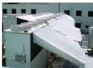
エアコン室外機の遮熱
