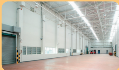
自然採光を用いた工場
