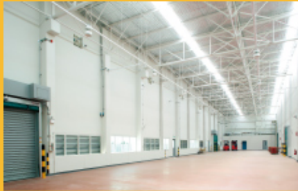
自然採光を用いた工場
