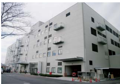
小牧工場 第1工場建屋
