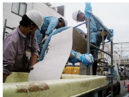
汚水管補強工事
