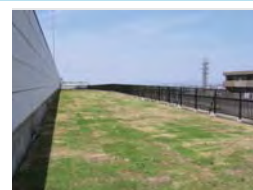
屋上緑化 (小牧工場)
