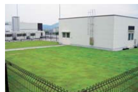
屋上緑化（小牧工場）
