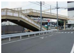
設置した歩道橋
