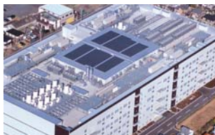
太陽光パネル（小牧工場）
